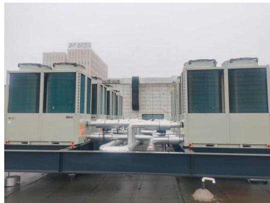
圖：風冷式冷水機組
