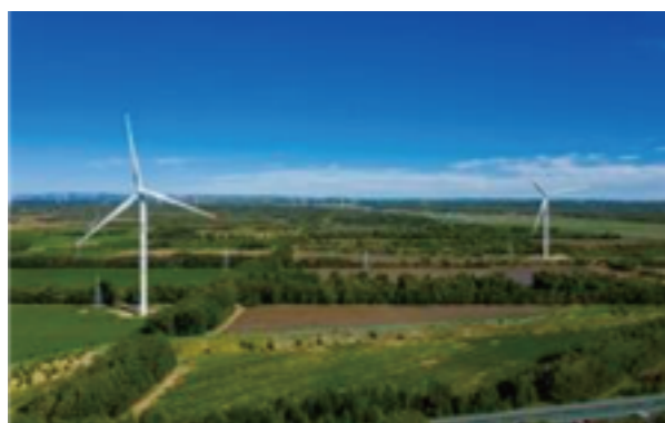
張家口 - 北京可再生能源綜合應用示範工程
