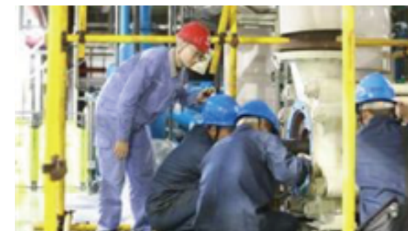
京西熱電檢修現場
