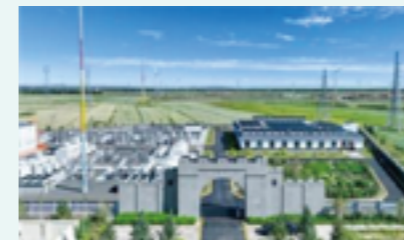
張家口—北京可再生能源綜合應用示範工程
