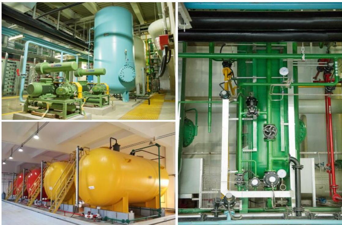
凝结水精处理系统设备实物图
