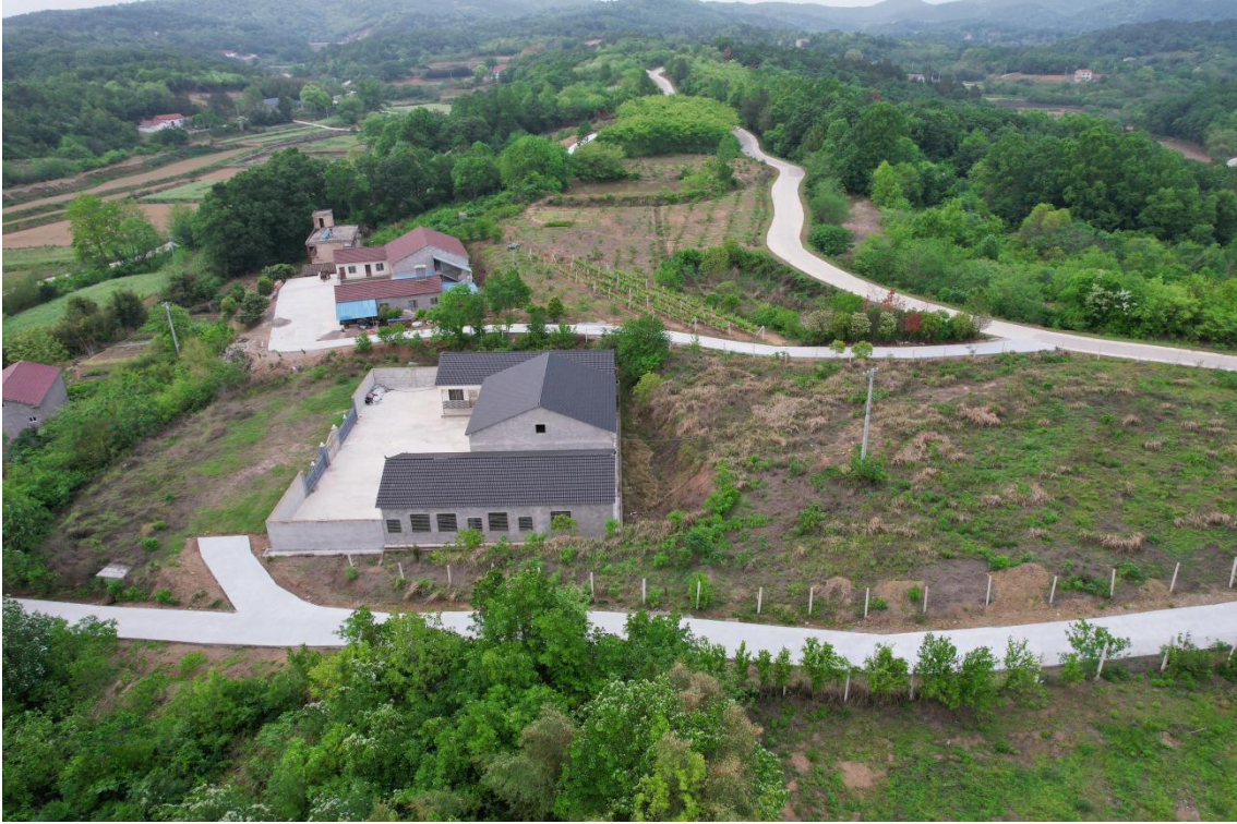
图 15 帮扶完成修建的京河村道路
