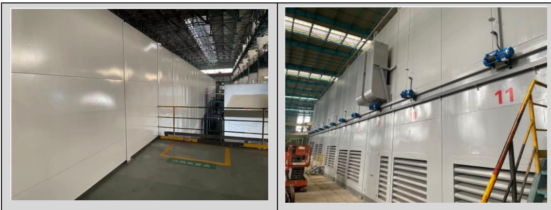
高一、高三工序风冷线区域风机噪声综合治理
