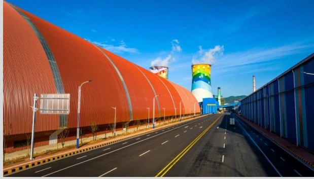
炼铁厂料场封闭环保改造工程
