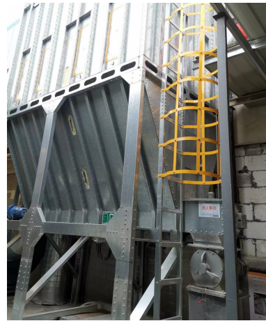
升级改造防爆式滤筒及布袋除尘器
