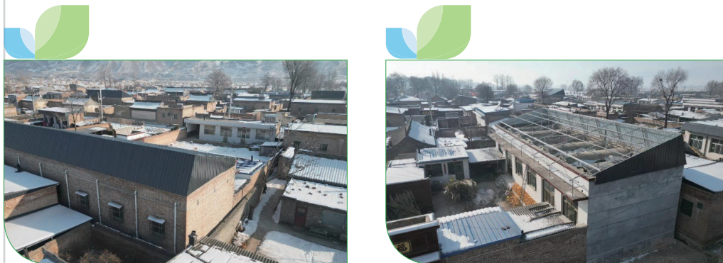
戶用光伏設備
