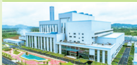
陸豐垃圾焚燒發電廠
