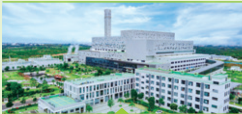
電白垃圾焚燒發電廠
