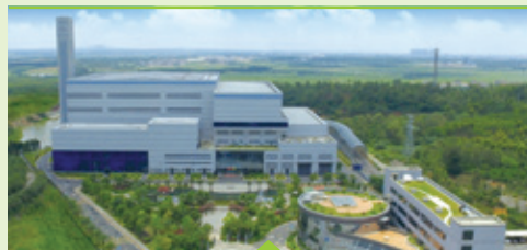
湛江垃圾焚燒發電廠
