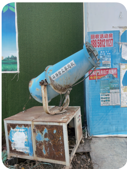
設置於工地各處的降塵裝置
