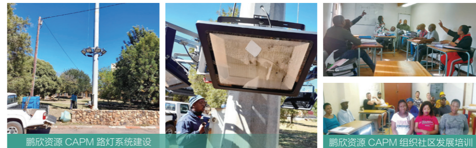
鹏欣资源 CAPM 路灯系统建设
