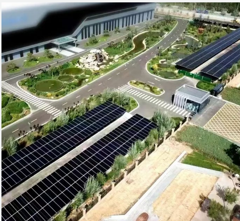
TCL 中环内蒙古产业园光伏项目
