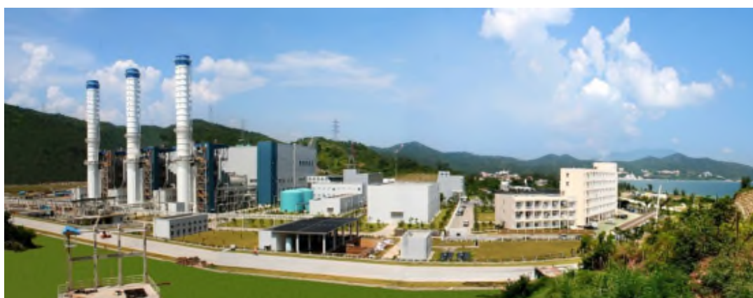
图 东部电厂（一期）项目外景
