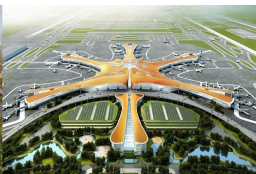
北京新机场航站楼
