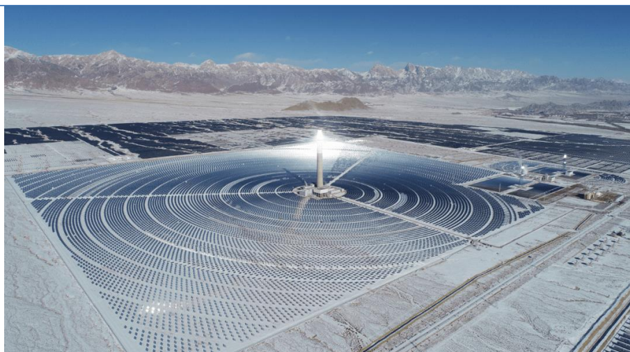
青海中控太阳能德令哈 50MW 塔式熔盐储能光热项目图示
