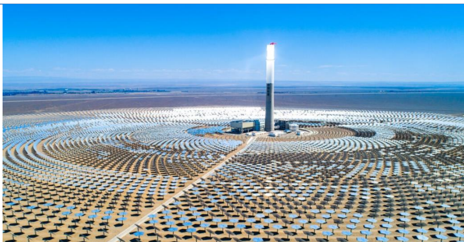
东方锅炉-新疆哈密 50MW 熔盐塔式光热发电项目图示
