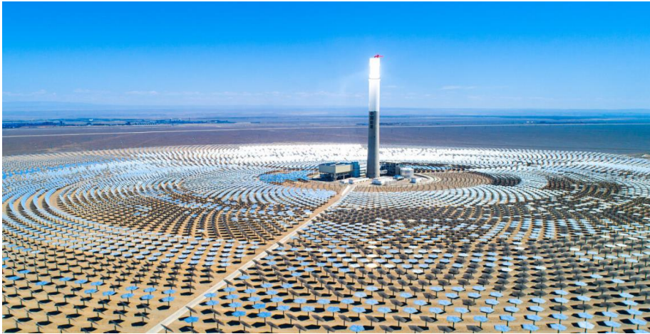
新疆哈密 50MW 熔盐塔式光热项目图示
