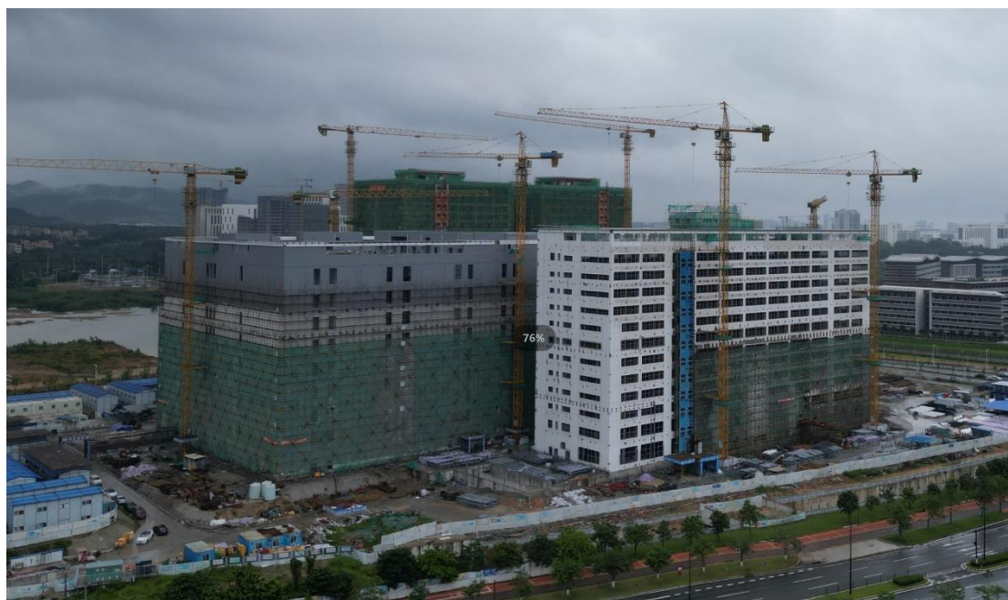
本次募投项目生产厂房（图中居中建筑物）建设现状（侧面）
