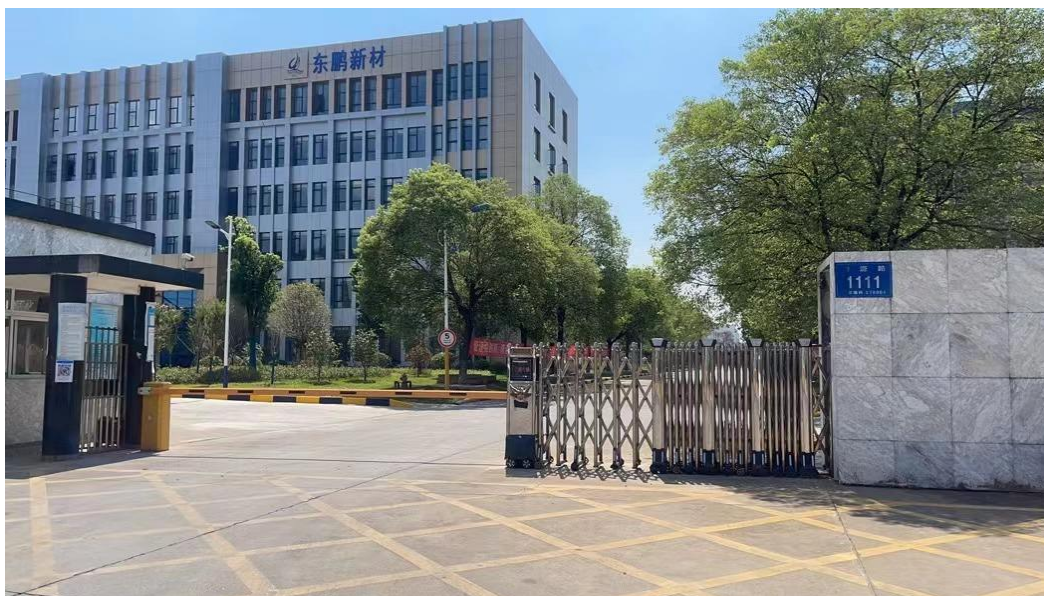
公司所属东鹏新材电池级氟化锂和铯钼盐工厂
