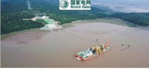
**全球首根XLPE绝缘500kV海底电缆(含软接头)**
