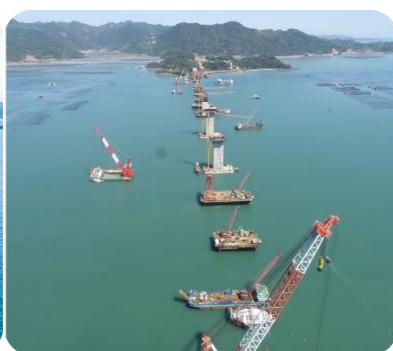
图 2 宁上高速东吾洋特大桥
