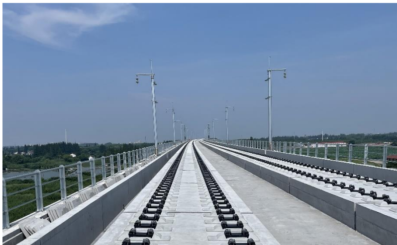
公司轨道扣件产品应用场景示意图 (沪苏湖高铁现场情况)
