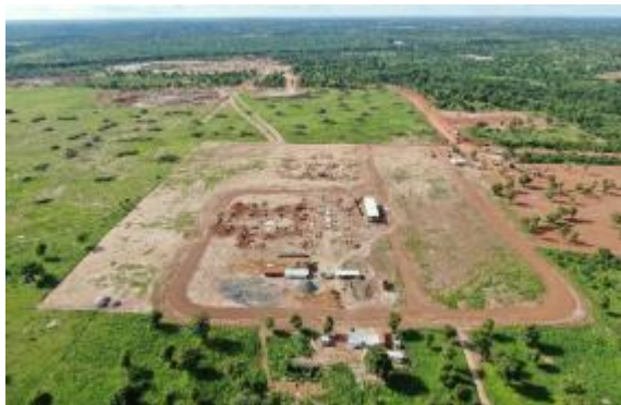
布谷尼锂矿采矿及选矿建设现场
