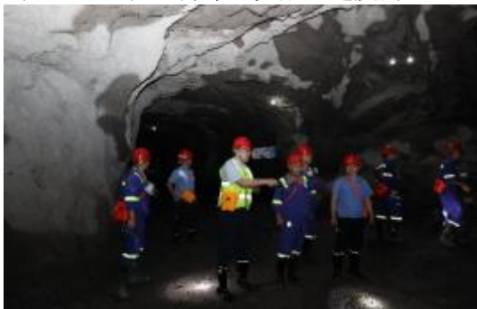
-120m~-360m 中段采矿工程建设项目现场
