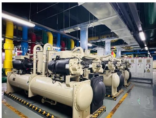
房山数据中心园区部署的水源热泵余热回收系统
