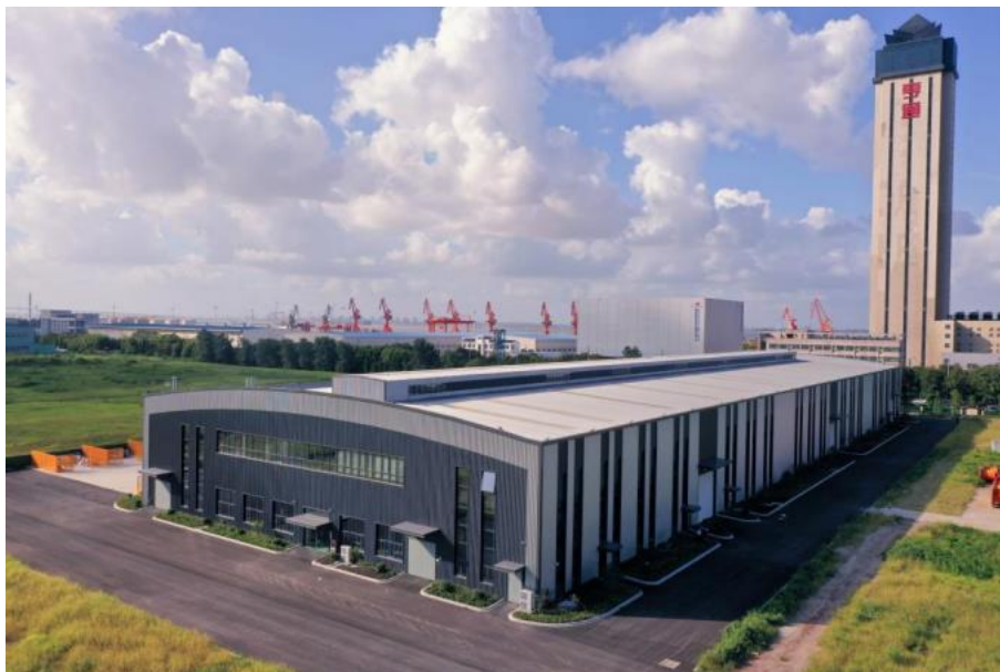
亨通高端制造业产业园项目一期
