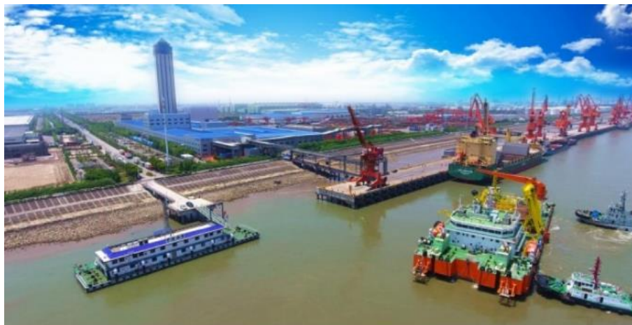
亨通国家电网舟山项目
