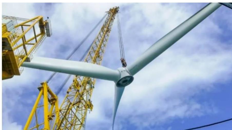
亨通浙能台州 1 号海上风电项目风机安装工程
