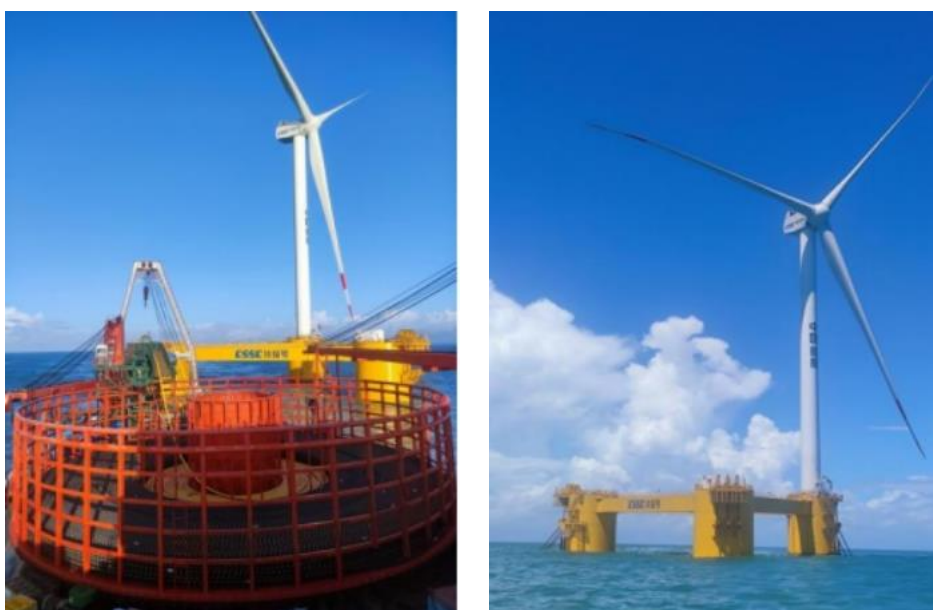
亨通动态海缆应用于深远海漂浮式风电机组“扶摇号”
