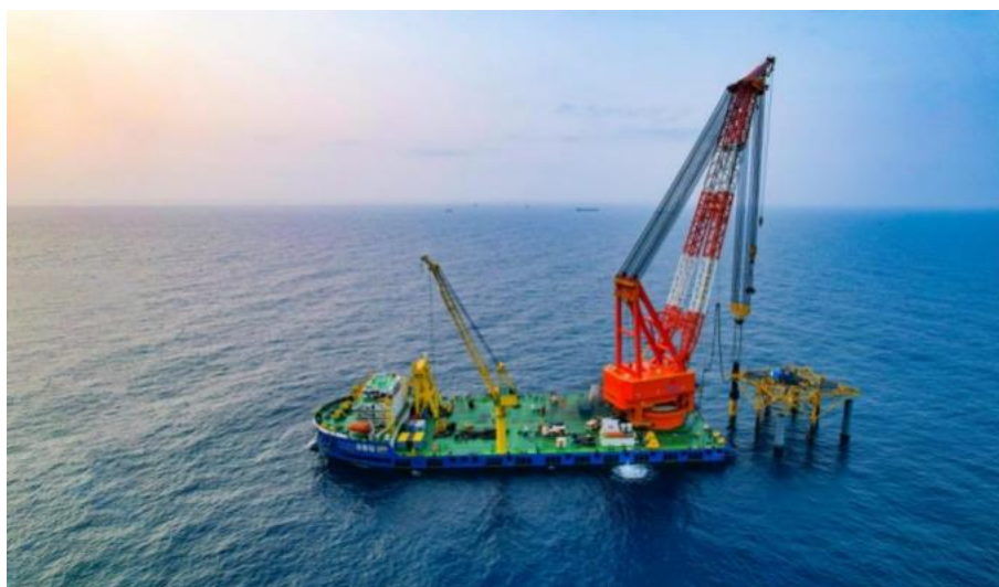
亨通广东明阳阳江青洲四海上风电项目
