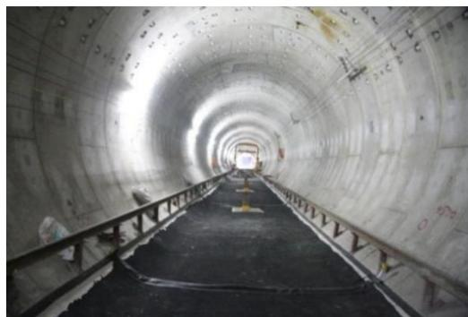
隔离式橡胶减振垫使用效果图
