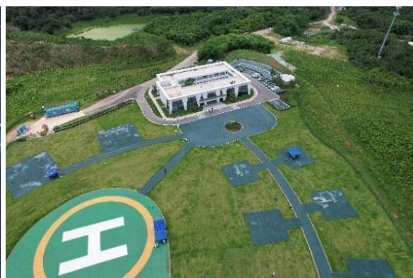
图 4 龙岗无人机测试基地建设
