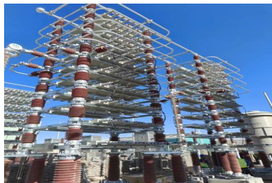
格尔木±400kV 换流站扩建工程
