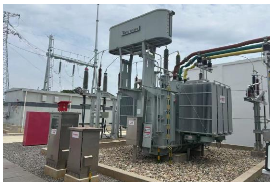
三宁磷石膏净化 110KV 变电站项目
