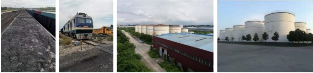
可利物流 铁路专用线
