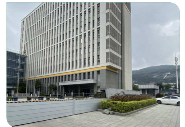
安装防洪挡板 ▲
