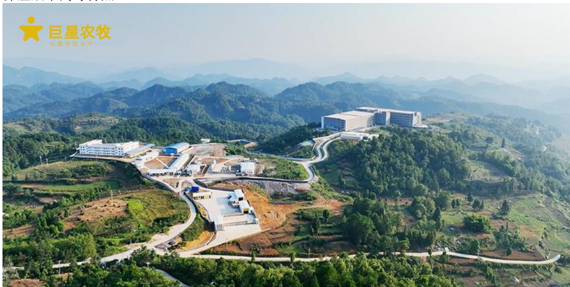
图 1：巨星农牧现代化楼房猪场
