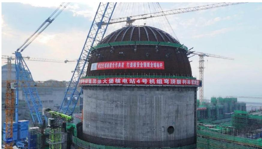
2024 年 6 月，辽宁徐大堡核电 4 号机组核岛穹顶吊装
