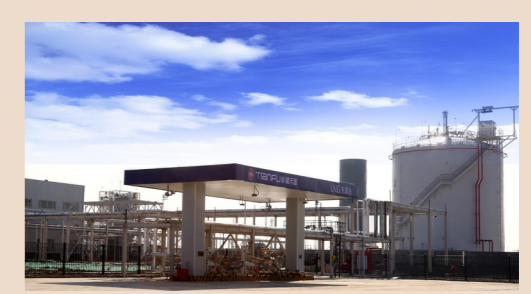
天富天源燃气储备配套液化工厂
