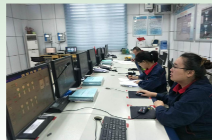
公司电厂脱硫运维集控室
