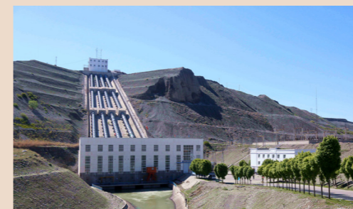
天富能源供水水利工程
