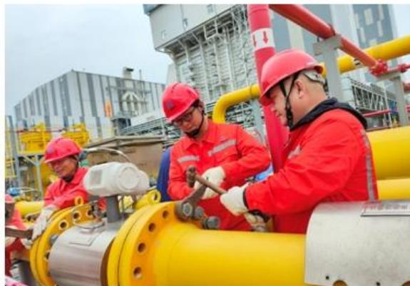
图：计量设备技术改造现场
