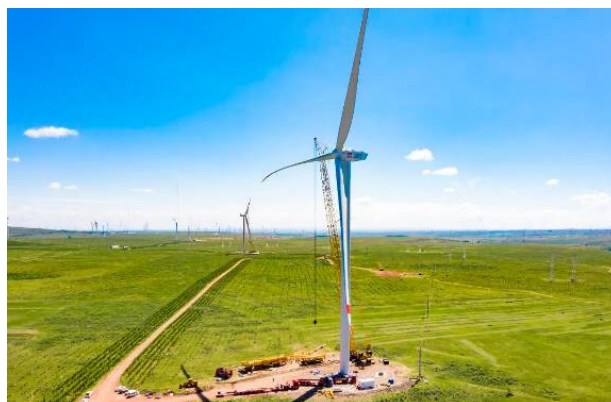
中国中车第一个自营风电场——内蒙古锡林郭勒盟后水泉(骆驼山)风电场全容量并网，项目年上网电量为 165000MWh
