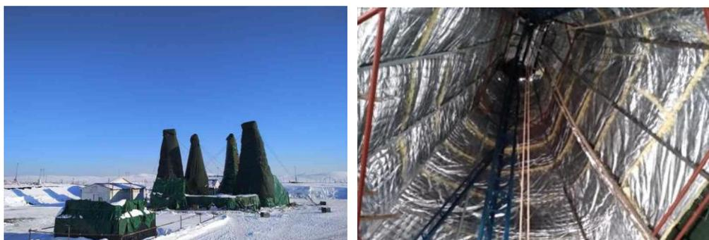
图表 5 哈萨克斯坦阿尔杰米耶夫矿通风罐笼井项目工程地面系统保温及钻塔顶部保温
