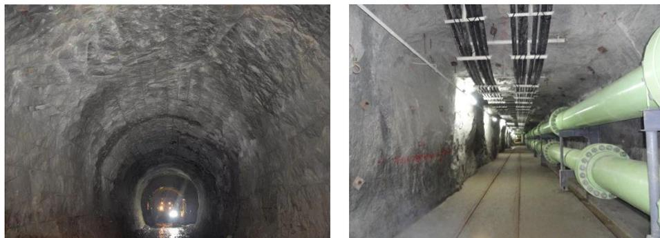
图表 13 无轨巷道（左图）及有轨巷道（右图）
