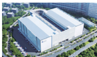
2 深國際西部公路樞紐物流園 (深圳寶安)#
