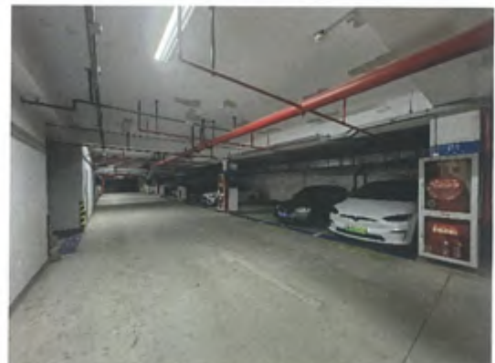
地下车库用房内部
