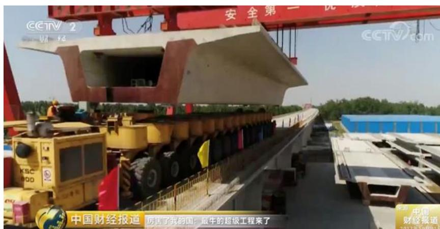
图 央视财经频道报道高铁运梁机案例
