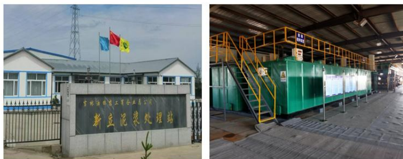
集中站作业现场
