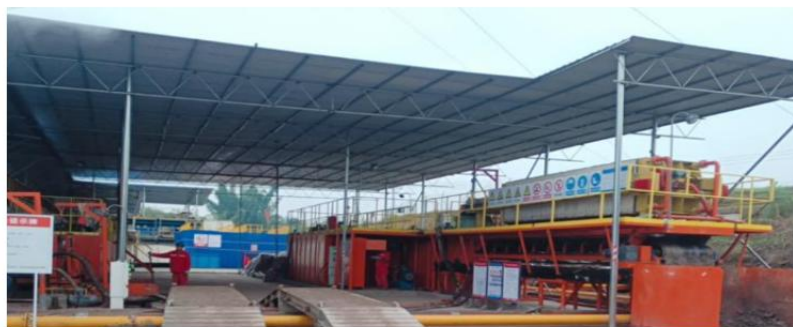
单井随钻作业现场
