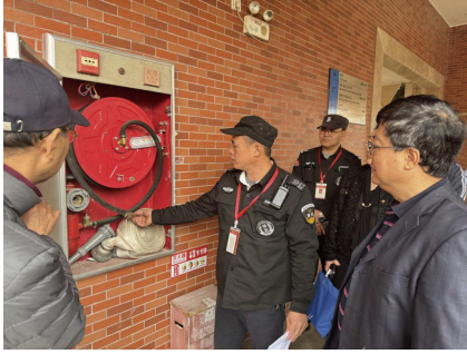
圖十一 校園消防設備的檢查、整改
