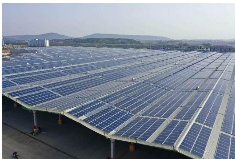
发行人江西丰城生产基地光伏厂房
