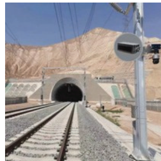
安裝在列車軌道上方
