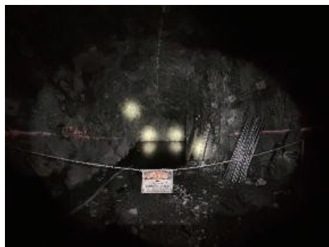
斜坡道掘進端面
