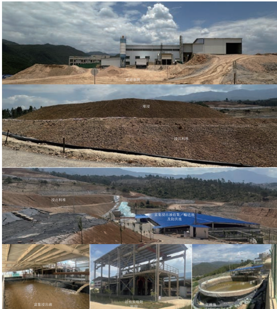
圖11-15：溪燈坪堆浸廠的主要設施照片
