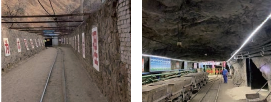
圖10-6：五中段主平洞入口及井底車場照片
