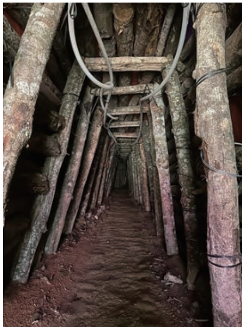
圖12-7：建造中的主富浸溶液收液隧道
