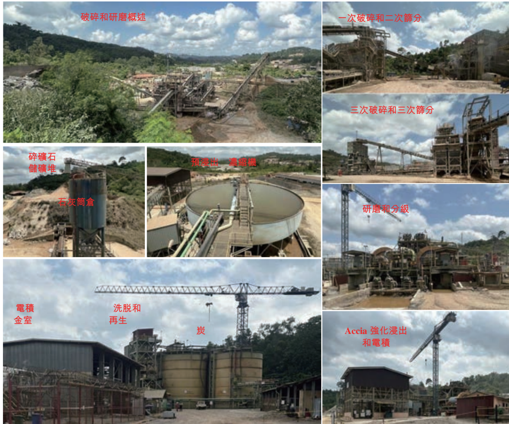
圖13-2：Wassa選礦廠照片
