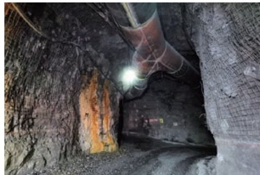
主斜坡道通風管
