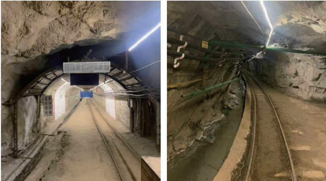
圖10-20：東風礦三中段平硐通道及巷道照片
