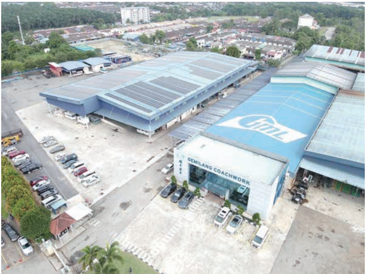
製造工場內光伏系統的照片
