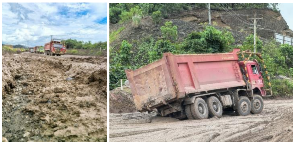
图 某国镍矿运输所使用的车型和泥泞运输道路
