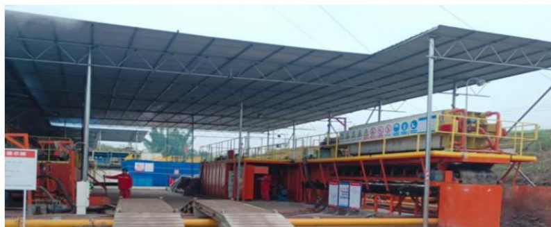
单井随钻作业现场
