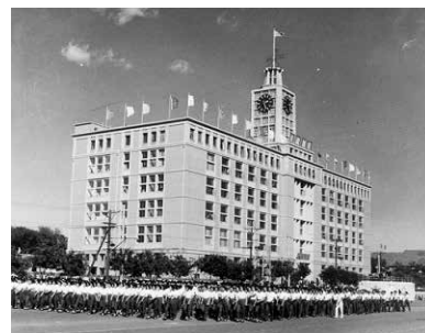
1958 年新建成的北京电报大楼
