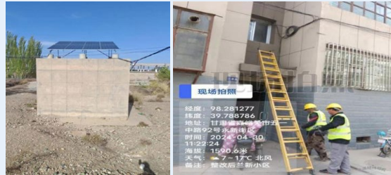
线路治理后的小区
