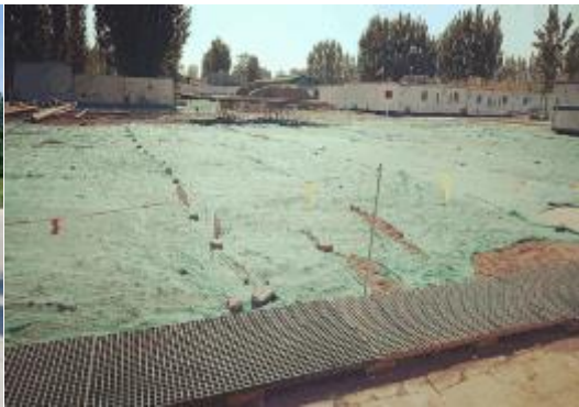
▲ 施工場所鋪設防塵網
