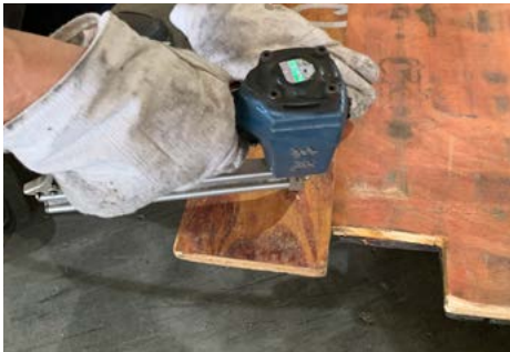
底板缺角修補
