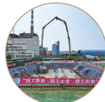
熱電機組改造工程
