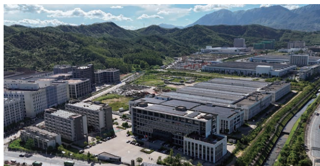
深汕乾泰工业园“光储充一体化”项目
