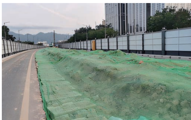
裸露土及易起尘物料覆盖
