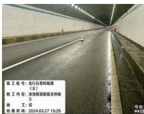
清洗隧道路面及侧墙
