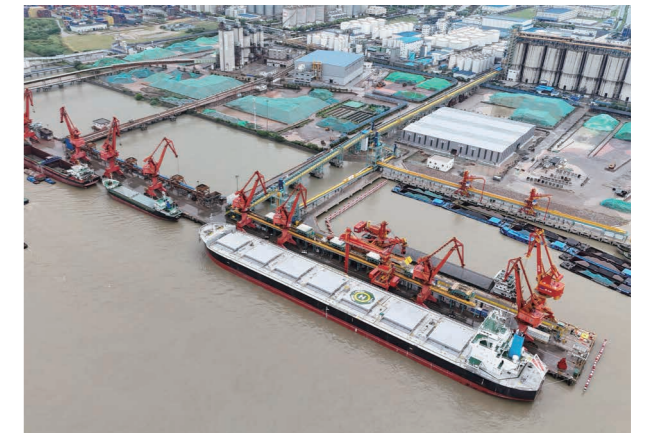
泰州永安码头改造项目
