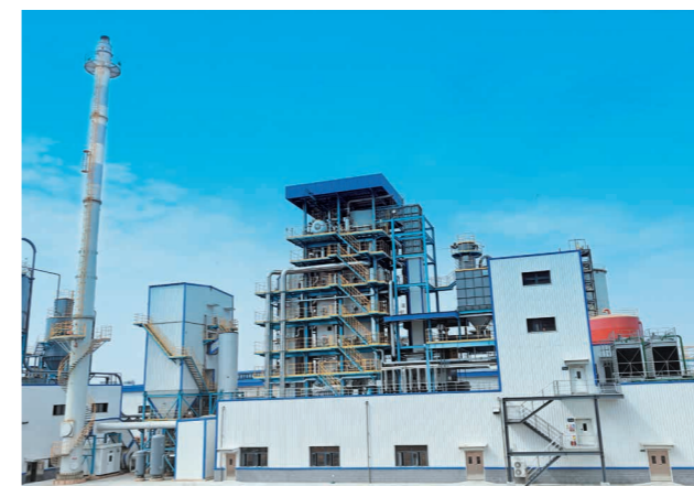
公司旗下长沙工厂的生物质锅炉
